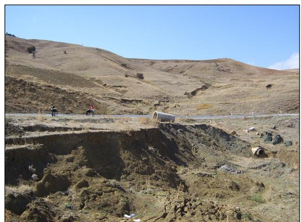
**Photo 04:** sapement de la chaussée sur une grande distance.
