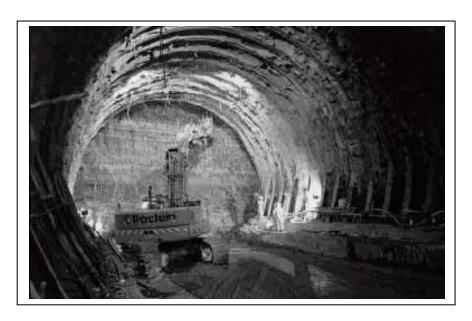
Fig.6: Creusement en pleine section.
