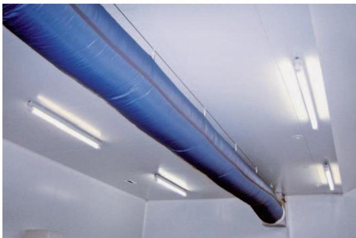
**Figure 52 : Gaine en textile pour couvrir les équipements**
