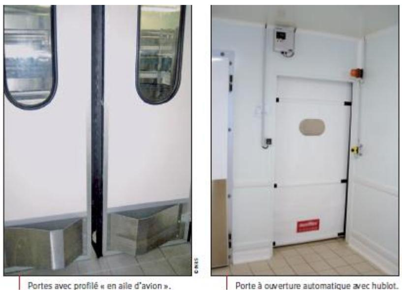
**Figure 28 : Photo d'une porte automatique avec hublot et porte avec profilé « en aile d'avion ».**
