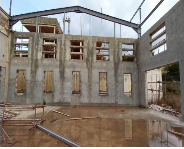
مبنى الورشات من الداخل .
