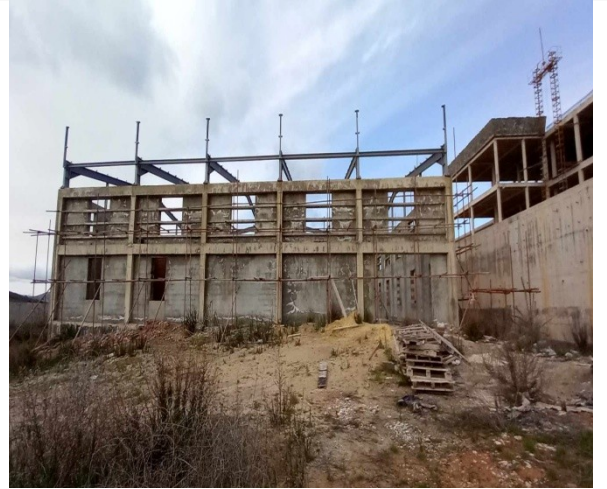
منظر جانبي لمبنى الورشات .
