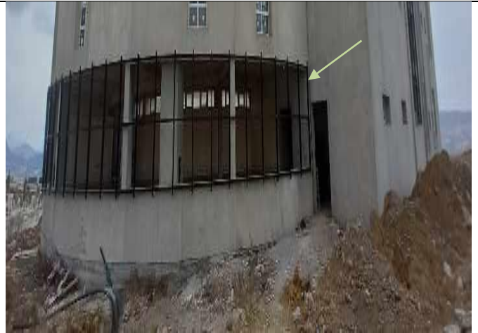
أشغال تركيب الواجهة الزجاجية
