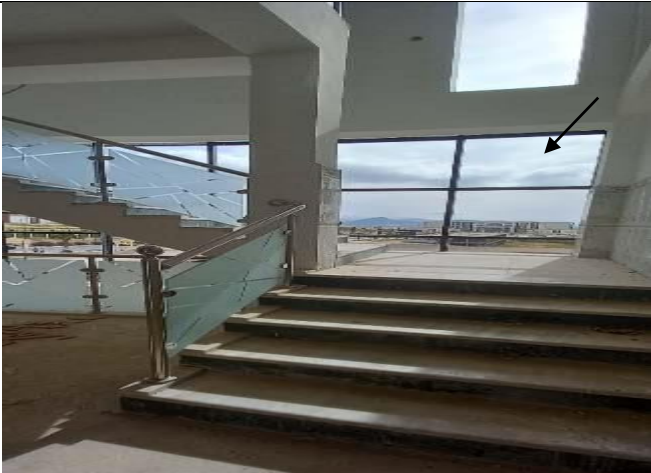
أشغال تركيب الواجهة الزجاجية
