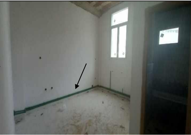
أشغال التدفئة المركزية بالغرف
