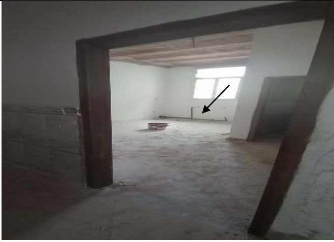
أشغال التدفئة المركزية بالغرف
