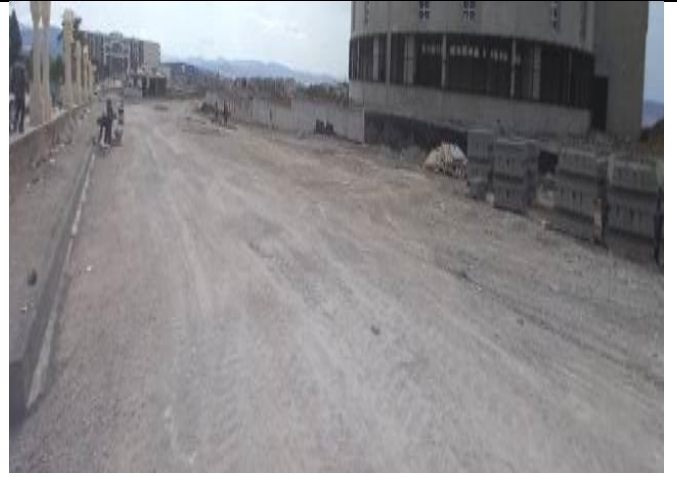
أشغال التهيئة الخارجية
