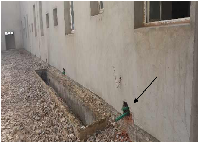
أشغال التدفئة المركزية بالغرف
