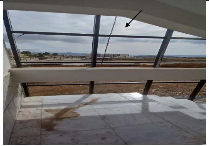
أشغال تركيب الواجهة الزجاجية
