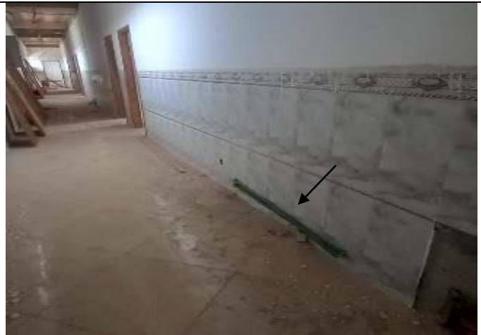
أشغال التدفئة المركزية بالرواق
