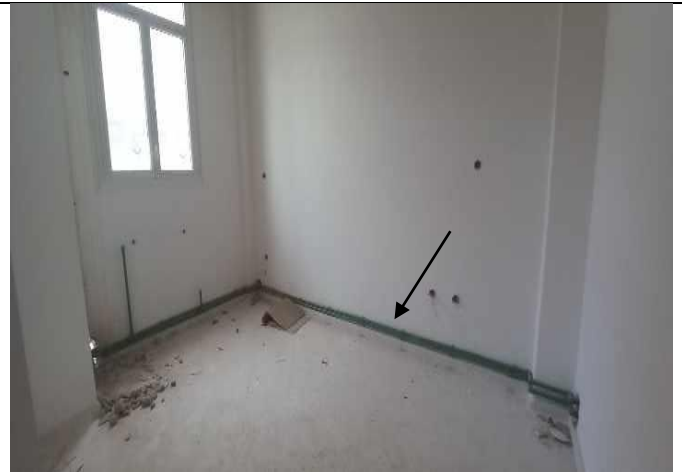
أشغال التدفئة المركزية بالغرف
