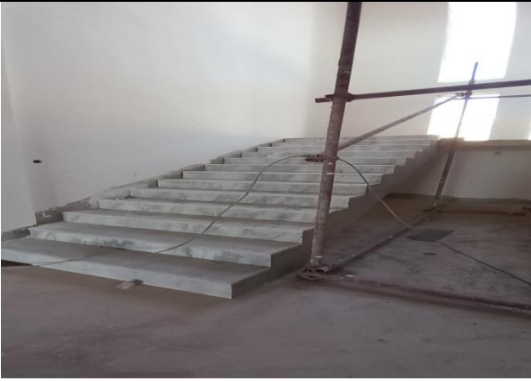
الأشغال تركيب وحدات الرخام
