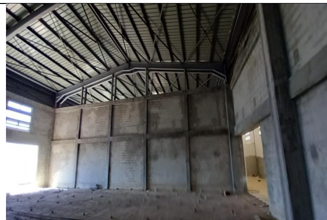
أشغال تركيب السقف الحديدي
