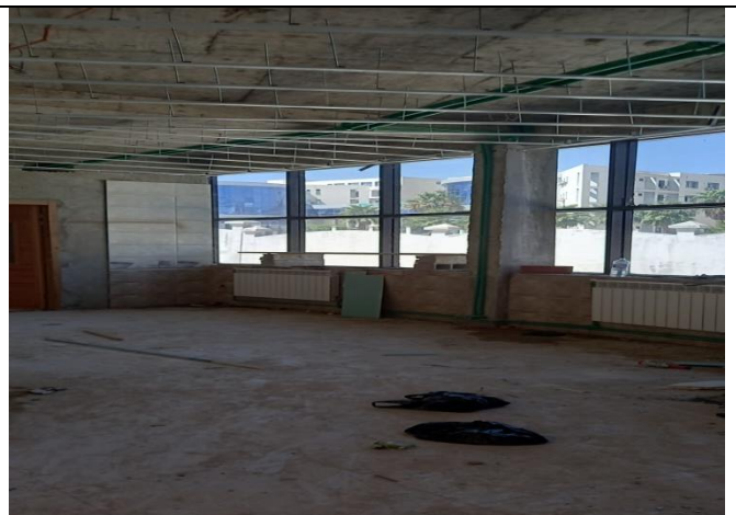
أشغال متوقفة للتدفئة المركزية والسقف المزيف
