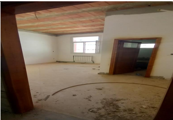
أشغال متوقفة للتدفئة المركزية والسقف المزيف
