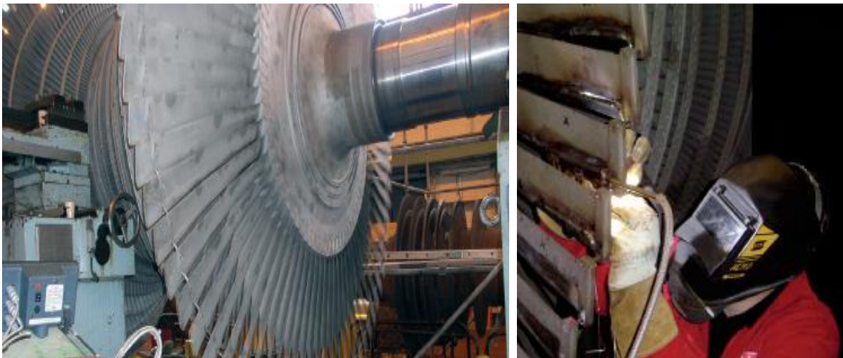
Figure IV.8: Maintenance de turbine à vapeur
