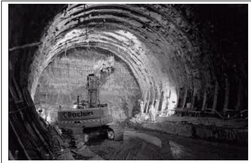
*Fig.6 : Creusement en pleine section.*
