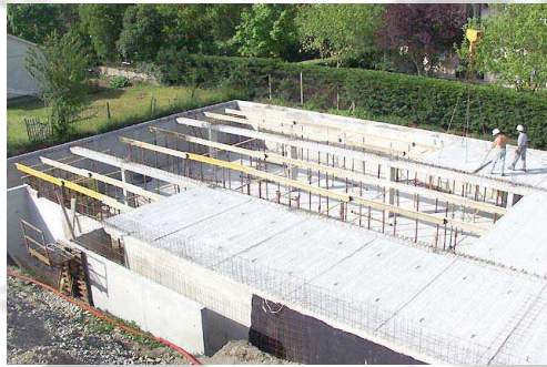
Photo I.25 : Exemple de plancher à prédalles
