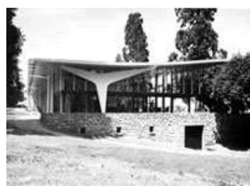
Photo I.5: Système de béquille unique, Buvette de la source Cachat, Evian, 1956, Constructeur : Jean Prouvé ( www.crit.archi.fr )
