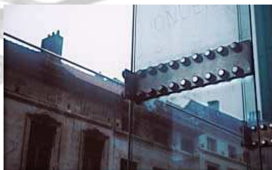
Photo II.33 : Verre Extérieur Agrafé.(www.energieplus-lesite.be).
