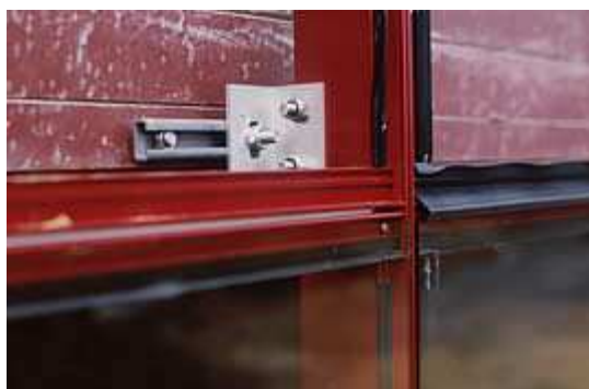
Photo II.35 : Exemple du Verre Extérieur Parclosé. (www.energieplus-lesite.be)
