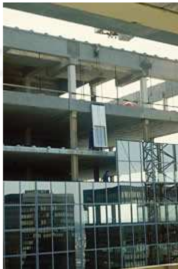
Photo II.27 : Exemple de façade en panneau.( www.energieplus-lesite.be ).
