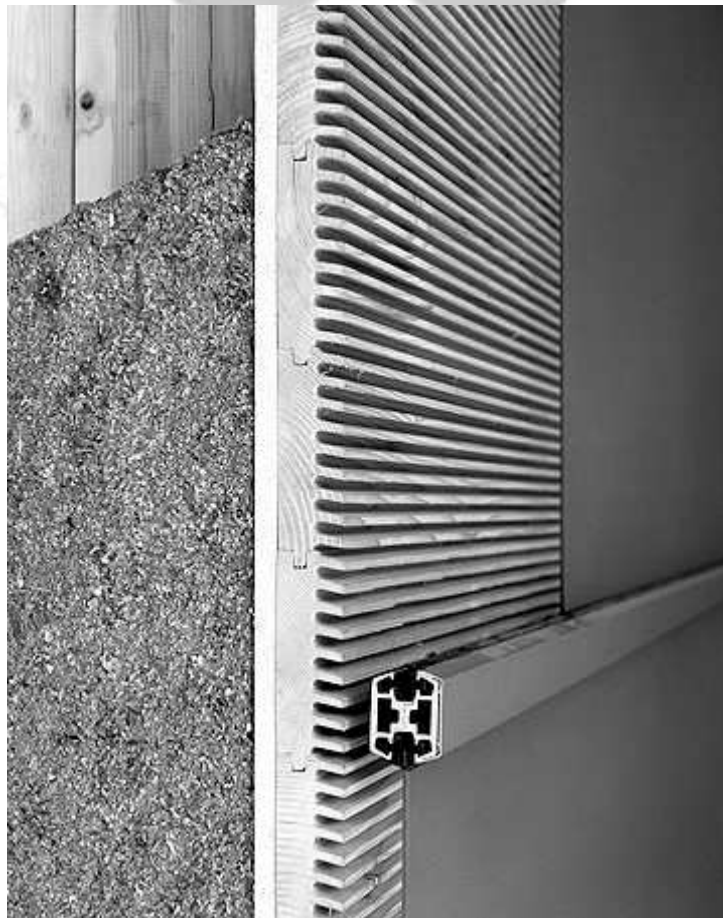
Photo II.46 : Façade active en lamelle de bois. ( www.charpente-concept.com )
