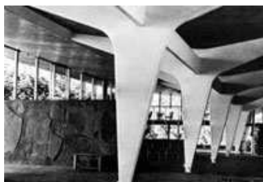
Photo I.5: Système de béquille unique, Buvette de la source Cachat, Evian, 1956, Constructeur : Jean Prouvé ( www.crit.archi.fr )
