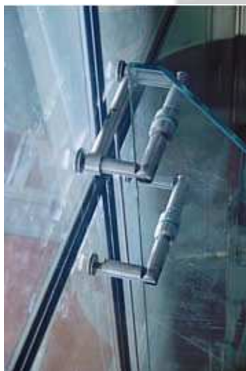
Photo II.33 : Verre Extérieur Agrafé.(www.energieplus-lesite.be).
