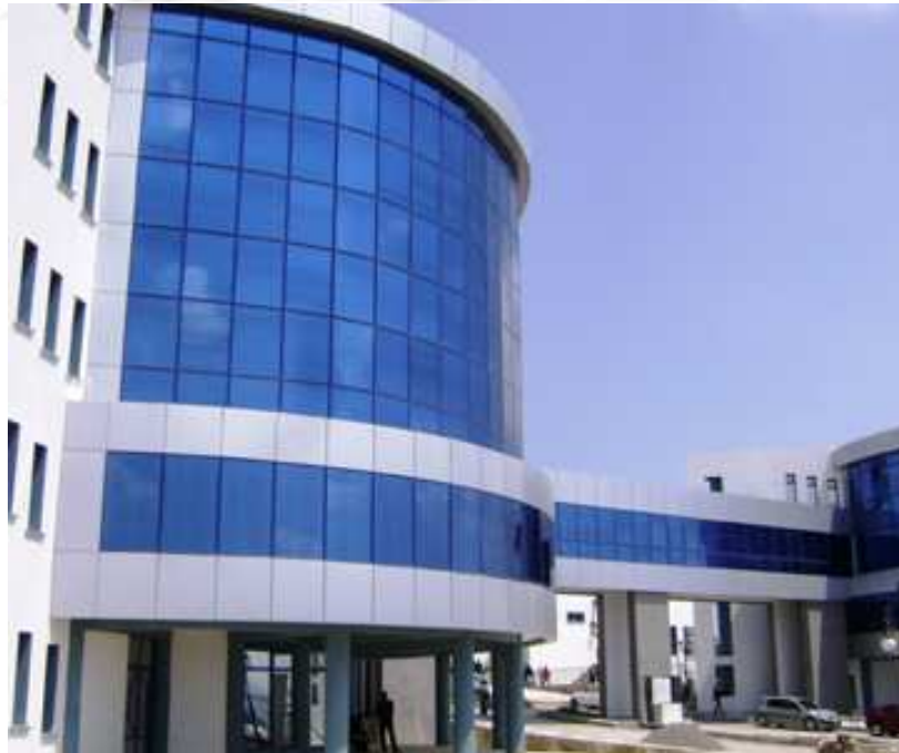
Photo III.14: Vue latérale de la façade étudiée.
