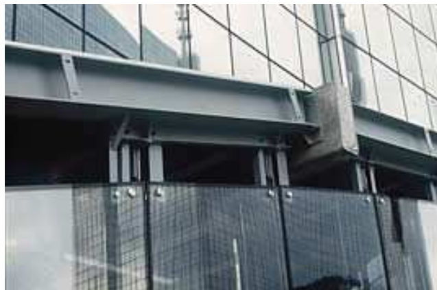
Photo II.32 : Exemple d'un mur en verre structurel. ( www.energieplus-lesite.be ).
