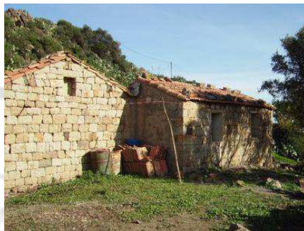
Photo II. 3 : Exemple d'un mur en brique d'une maison kabyle au village Ath yaala.
