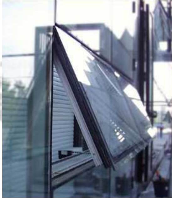
Photo II.42: Entrée d'air d'un canal. (Croix et Bassil,2008-2009)
