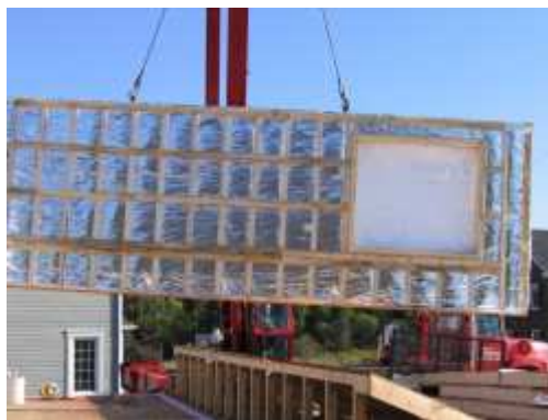
Photo I.20 : Exemple d'un mur préfabriqué en bois. ( www.sturcturedacote.com )
