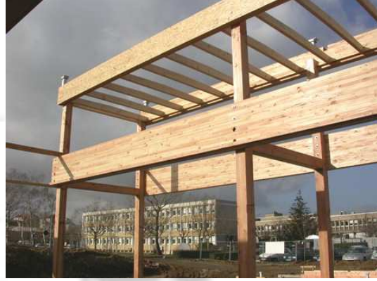
Photo I.14 et Photo I.15: Exemple de Structure primaire de l'ossature bois.(www.certu.fr).
