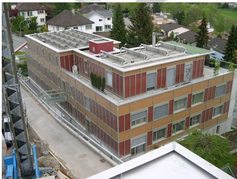
Photo II.49: Exemples de construction avec des façades solaires.( www.charpente-concept.com )
