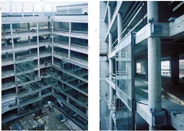
Photo II.28 : Montage d'une façade en panneaux. (www.energieplus-lesite.be)
