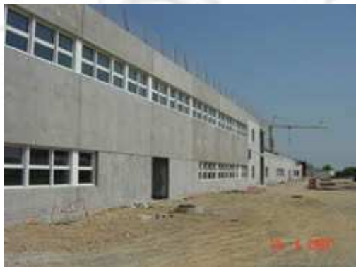
Photo II.27 : Exemple de façade en panneau.( www.energieplus-lesite.be ).
