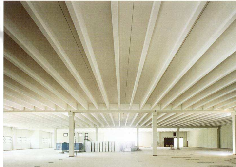
Photo I.24 : Exemple de plancher nervuré double T (Elliot POLANIA, 2006)
