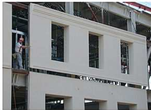
Photo I.21 : voile en panneaux préfabriqués. Photo I.22 : Exemple d'un mur de façade en béton préfabriqué. (www.archiexpo.fr)
