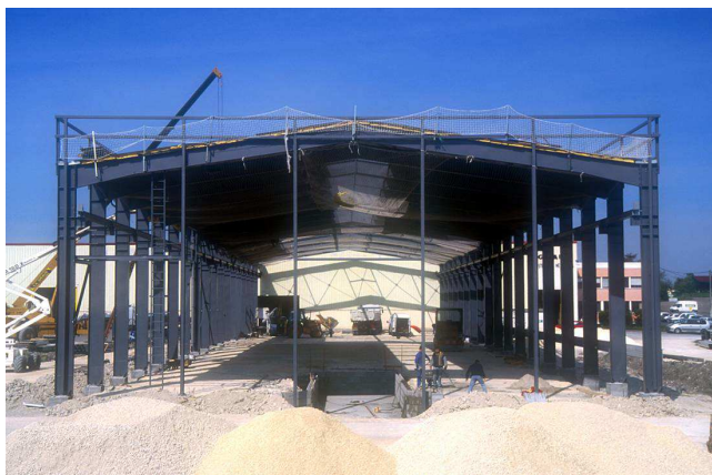
Photo I.11 : construction à portique métallique.
