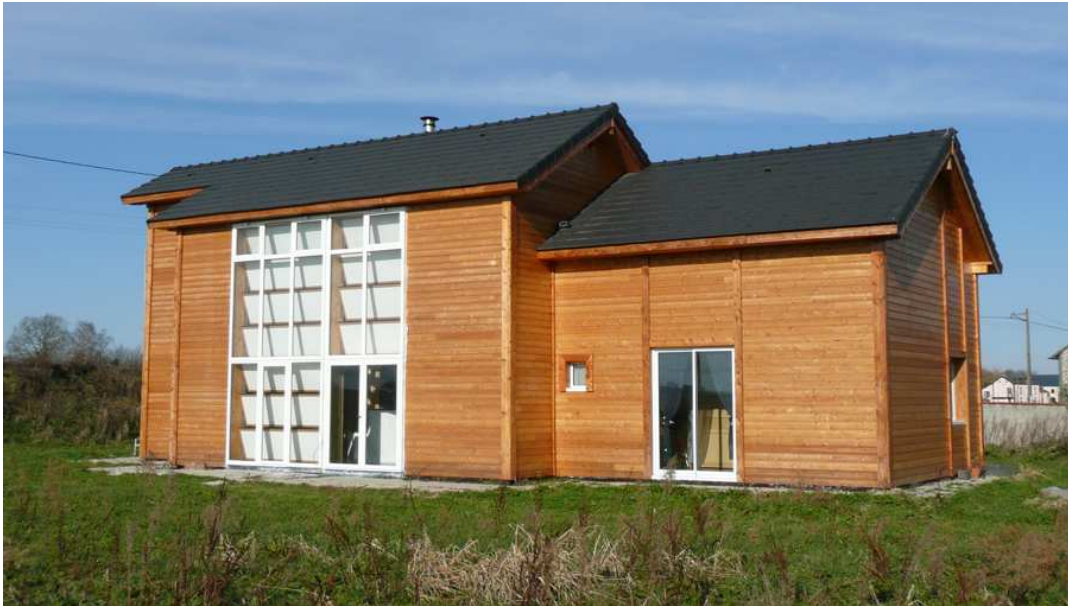
Photo II.50: Une façade intelligente grâce à des brise-soleil automatisés .(Frédérique Vergne,2009).
