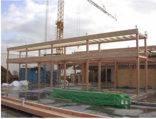
Photo I.14 et Photo I.15: Exemple de Structure primaire de l'ossature bois.(www.certu.fr).
