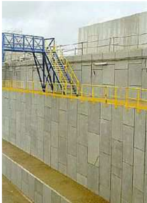
Photo I.21 : voile en panneaux préfabriqués. Photo I.22 : Exemple d'un mur de façade en béton préfabriqué. (www.archiexpo.fr)
