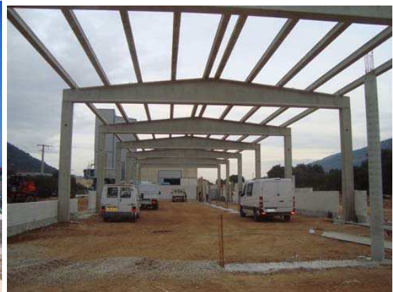
Photo I.12 : construction à portique en béton.(www.ytong.f)
