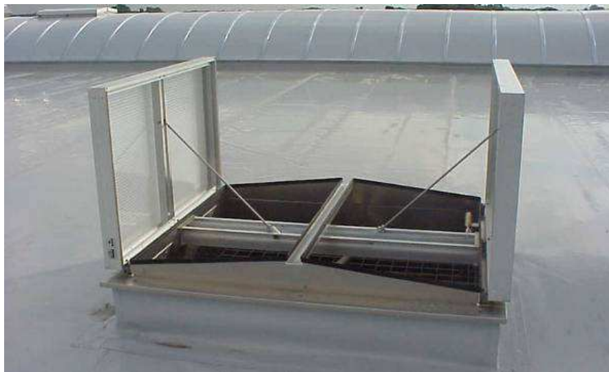
Fig 74 : Conduit de fumée sur le toit
