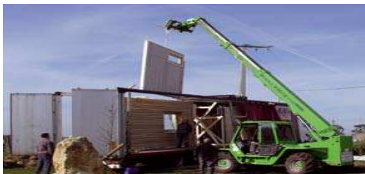
Figure 79 : levage des composants constructifs par une grue automotrice 54 .
